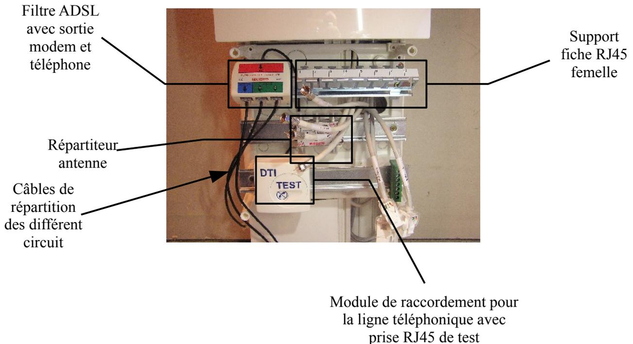
Pour les circuits réseau, il vous suffit de clipser la fiche RJ45 femelle (à l'aide d'un tournevis si
